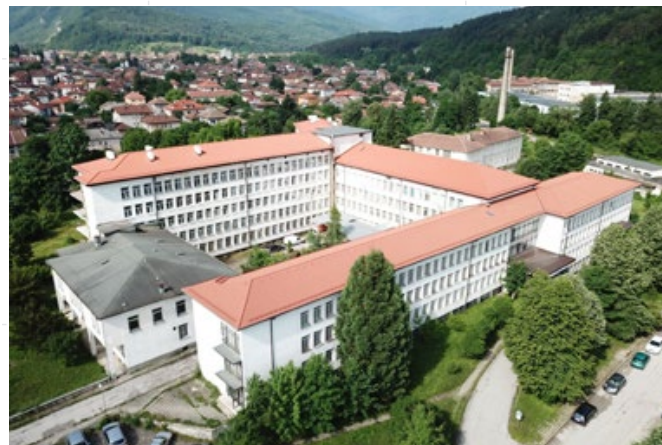
МБАЛ „Проф. д-р Ал. Герчев“ в Етрополе е с ремонтиран покрив по програмата „Българските добродетели“
